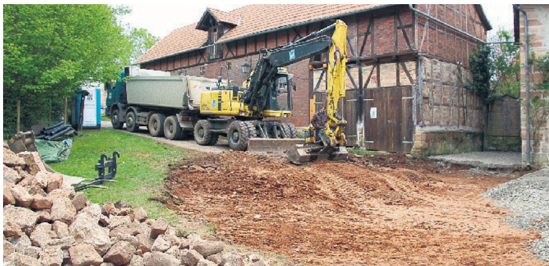
Bei den Bauarbeiten wird besonderer Wert auf neue Bodenbeläge für den Museumshof geachtet. Bei den Arbeiten dazu, hatte man sogar einen alten Brunnen gefunden.
