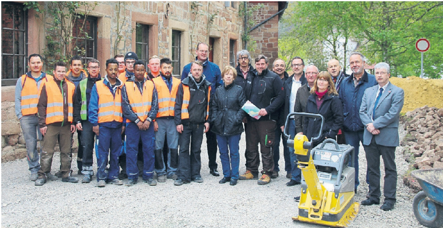
Gemeinsam mit den 12 Auszubildenden eröffneten die Verantwortlichen die Baustelle in der vergangenen Woche offiziell. Foto: Wehr
